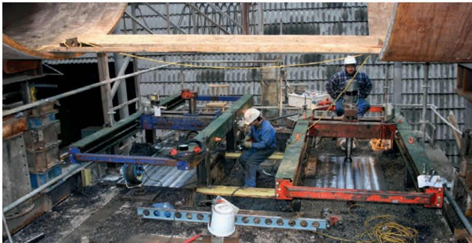
Um schnellstmöglich eine ebene, aber geneigte Fläche herzustellen, werden bei diesem Rohrofen für Zement im Rund-um-die-Uhr-Einsatz die Traglagerfundamente ausgefräst.
