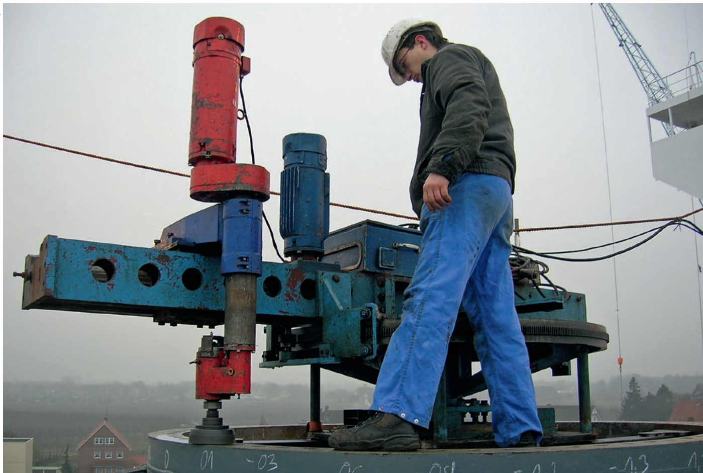
Die Arbeitsorte der Spezialisten für mobile Zerspänung von Becker sind mitunter spektakulär – so wie die Rundfräsarbeiten mit einem Durchmesser von ungefähr 3.000 Millimetern an einem Turmflansch.
